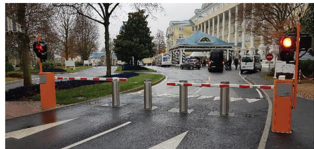
Eine Geschwindigkeit von ca. 4-5 Sekunden beim Ausfahren lässt sich zudem bei hydraulischen Anlagen durch die E.F.O-Funktion (Emergency Fast Opening) mittels eines zusätzlichen optionalen Druckspeichers auf bis zu ca. 1 Sekunde reduzieren.
