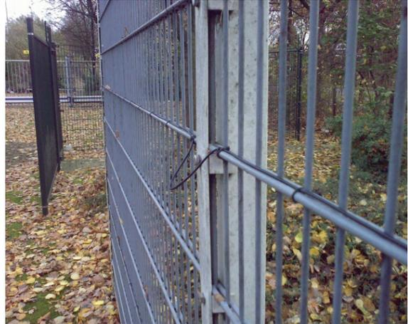
Das Mikrofonkabel sollte immer eng an der zu überwachenden Struktur anliegen (maximaler Kontakt). Um ein berührungsloses Überwinden des Zaunes ohne Hilfsmittel zu verhindern, wird eine Zaunhöhe von mindestens 1,6 m empfohlen. Tore und Türen können ebenfalls überwacht werden. Da Tore und Türen ein anderes Schwingungsverhalten als der Zaun aufweisen, werden sie in der Regel als separate Zone installiert. Die Empfindlichkeit dieser Zone kann daher separat parametrierbar werden.
