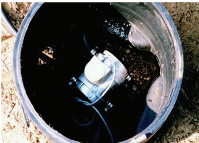
Das System kann in praktisch jedem Untergrund und unter jede Art von Oberfläche (Asphalt, Pflasterungen, Rasen, Erdreich usw.) verlegt werden. Nur die Verwendung unter Betonböden ist nicht möglich. Jeder Sensor kann maximal 100 m Länge überwachen.
