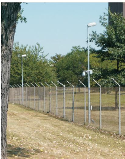
Digitale Zaundetektionssysteme werden sowohl auf Maschendraht, Streckmetall und Gittermattenzäunen eingesetzt, als auch auf unterschiedlichen Auslegertypen (gerade, abgewinkelt, Y-Form, S-Draht-Rolle etc.).
