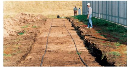
Jede Überquerung der Sensorschläuche erzeugt eine Druckänderung zwischen den beiden Schläuchen, die durch einen Sensor aufgenommen und verstärkt wird. Mikroprozessorgesteuerte Signalverarbeitung mit spezieller Software und intelligenter Elektronik werten die Signale aus und entscheiden über alle möglichen Alarme wie Voralarm, Hauptalarm und technischen Alarm.
