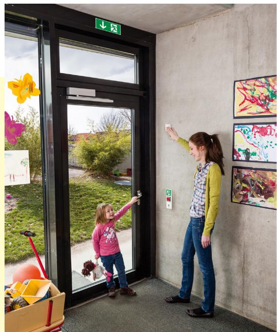
den. Ist eine Brandmeldeanlage angeschlossen, geschieht dies zusätzlich zur manuellen Freigabemöglichkeit bei der Erkennung eines Gefahrenkriteriums automatisch durch den Notschalter. Bei Stromausfall ist die elektrische Verriegelung automatisch deaktiviert. Dies ist durch das Funktionsprinzip (ohne Strom = offen) gewährleistet.
