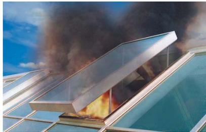
Reduziert werden diese Bedrohungen, wenn Brandrauch systematisch über Fenster, Rauchklappen o.Ä. ins Freie abgeleitet wird. Auch in Lagern, in denen die Bauvorschriften dies nicht ausdrücklich vorsehen, bieten sich dazu spezielle Rauch- und Wärmeabzugsanlagen an, die Rauch und damit die giftigen Gase aus dem brennenden Objekt herausführen. Gleichzeitig wird für eine
